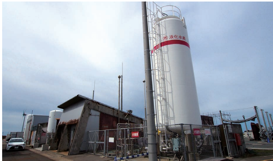
JAXA能代ロケット実験場に設置された液化水素タンク。液体水素はロケットの燃料に使われており、実験場で燃焼実験などが行われている
