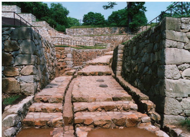
石垣で守られた大手虎口(おおてこぐち)の通路(西から)
