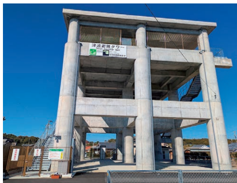
市内に新しく建設された津波避難タワー
