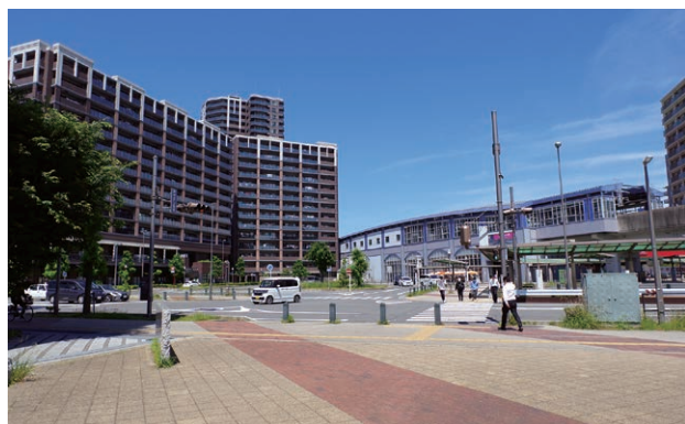
TXの開業を契機に進められた三郷中央駅周辺のまちづくりは、まさに三郷市の中心軸を構築する事業となった
