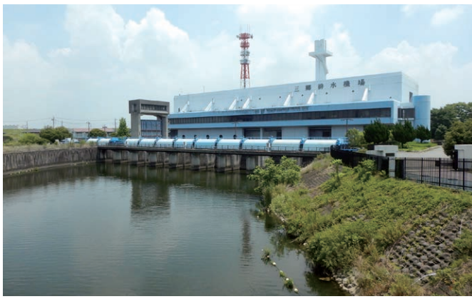
水の都・三郷市の治水事業の要「三郷排水機場」(手前の水流は三郷放水路)
