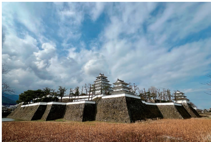
島原城跡 本丸南東隅外周石垣
