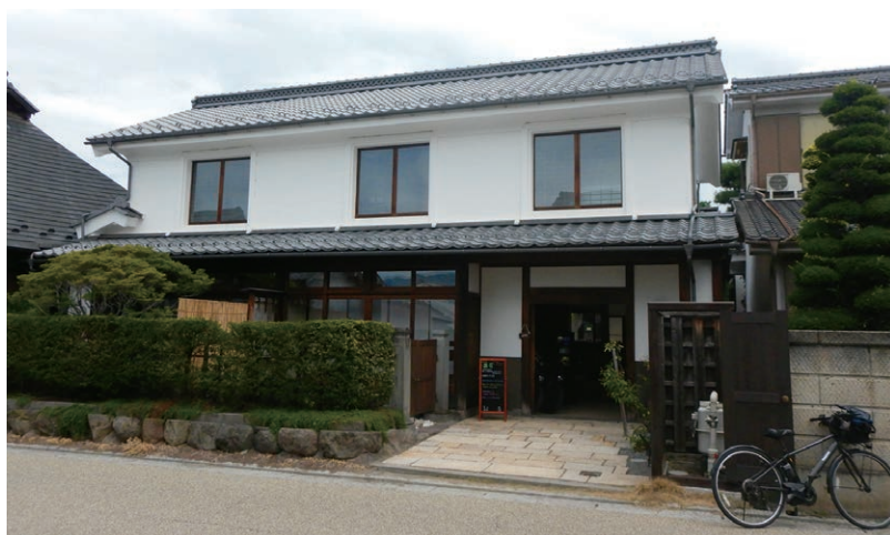
海野宿に設置された滞在型交流施設「うんのわ」は、移住希望者・観光客の宿泊体験施設のほか、カフェスタイルの交流施設としても機能
