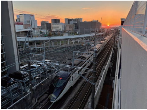
開発が進む新鎌ヶ谷周辺地区 スカイライナー（手前）と建設中の商業棟（奥）
