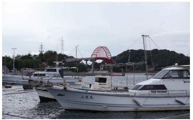
昭和45年完成の笠戸大橋は美しいアーチが特徴的なランガートラス橋。橋の下を船舶が行き来する様子は下松市を代表する「映え風景」の一つです。
