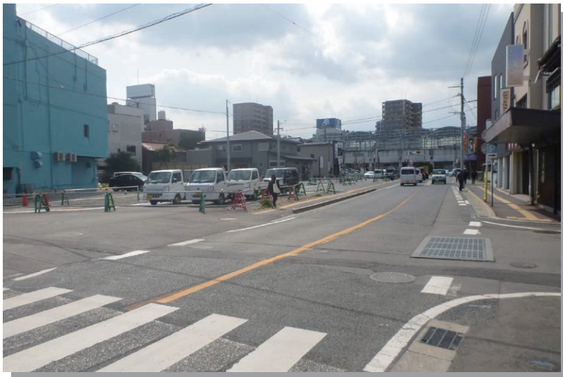
道路拡幅が進む 行橋駅前通り
