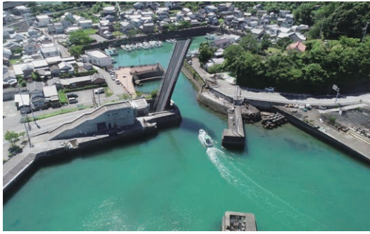
手結港可動橋
