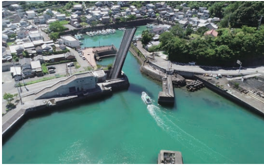
手結港可動橋
